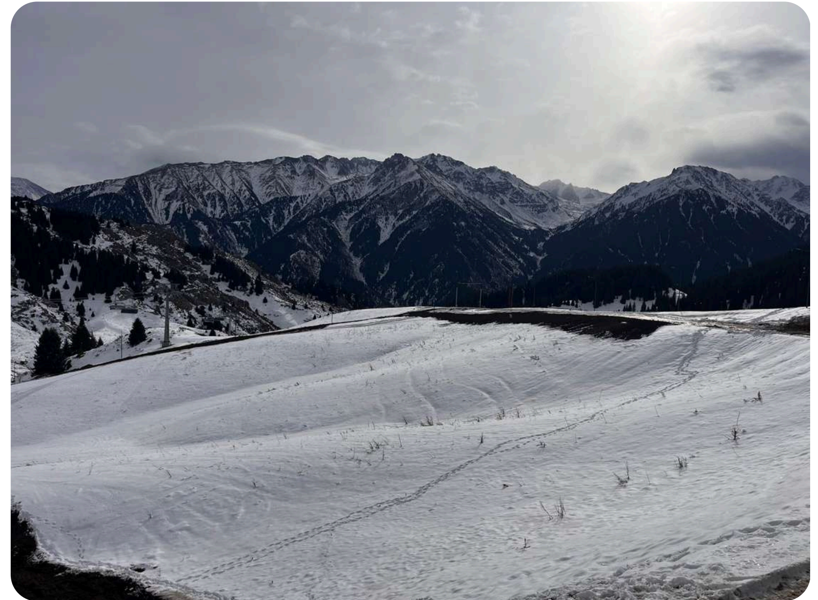
Установка инсталляций на склоне
