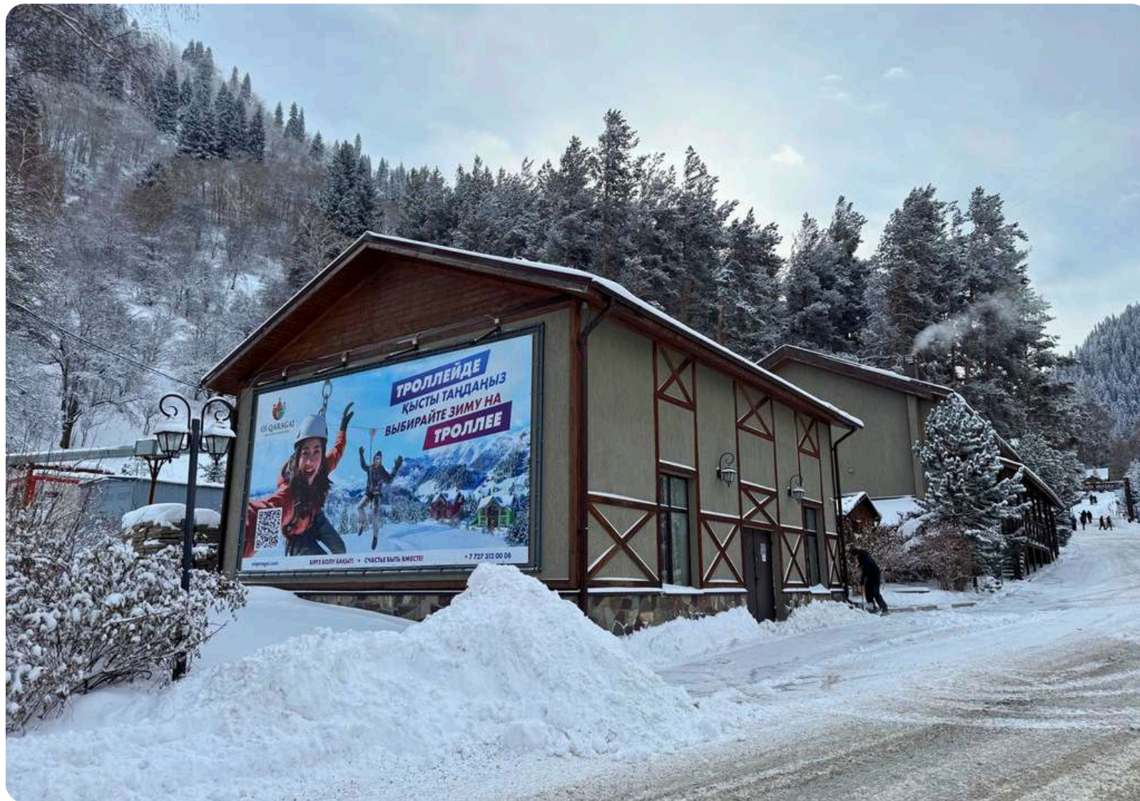
Конструкция на здании Размер: 7,6м x 3,4м
